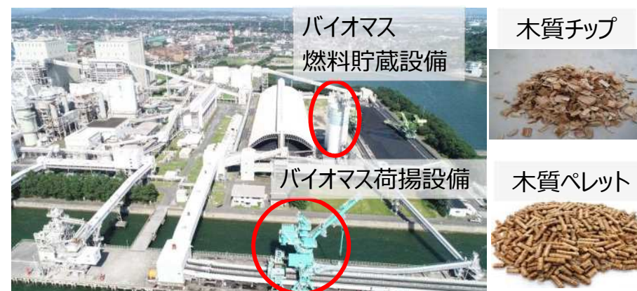
新小野田発電所バイオマス設備
